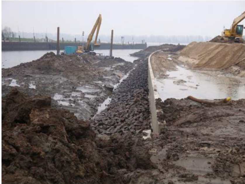
Bauarbeiten im Dezember 2013
