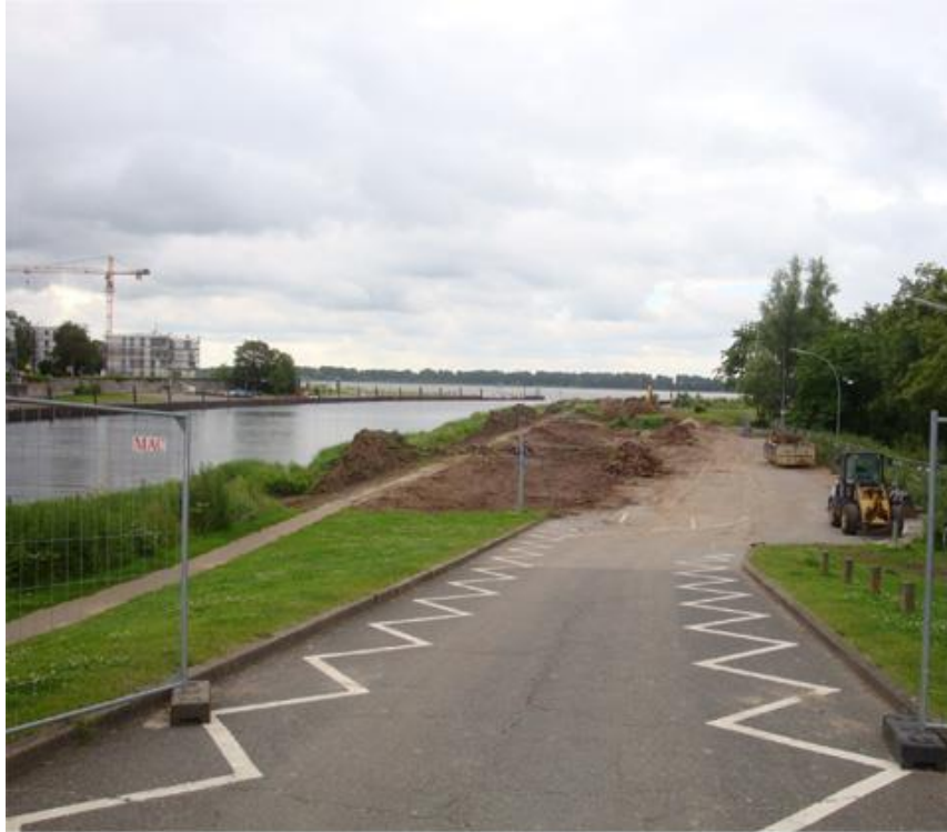
Die ersten Bauarbeiten am Schulauer Hafen im Juni 2013
