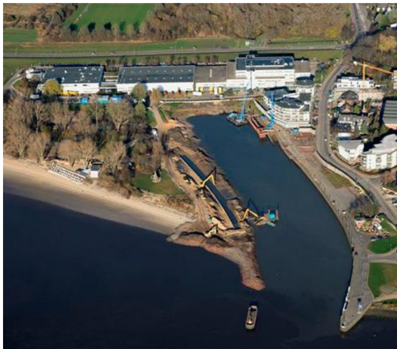
Luftaufnahme der Bauarbeiten im Dezember 2013
