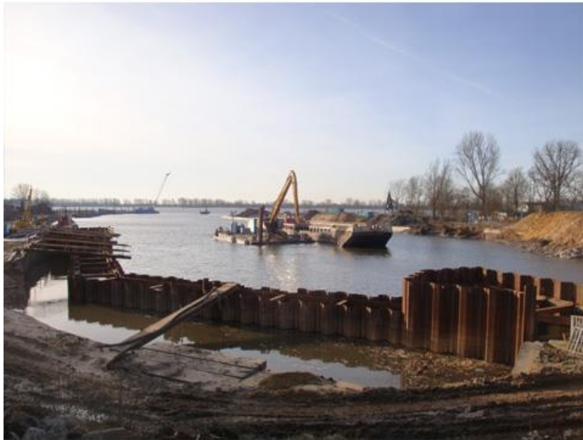
Die Baustelle im Februar 2014
