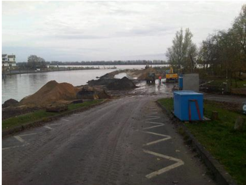
Bauarbeiten am Schulauer Hafen im November 2013
